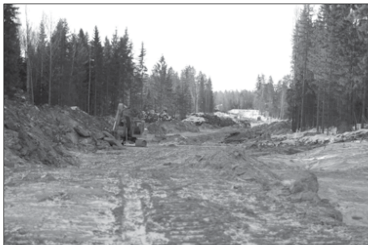
Lintulaaksontien jatko rakenteilla, tilanne 6.3.2011.
