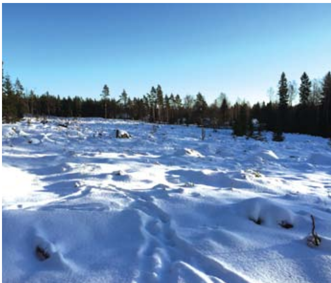
Uusia pientaloja tulee Hämeenkieläntien länsipuolelle, lähelle Hämeenkielää. Alueen viemärintityöt ovat käynnissä.
